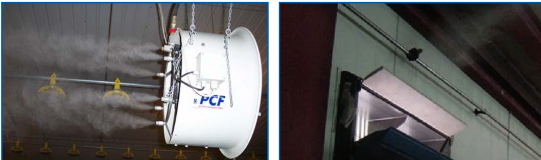
Şekil 16: Civciv döneminde sisleme cihazları kullanılarak nemin artırılması.
