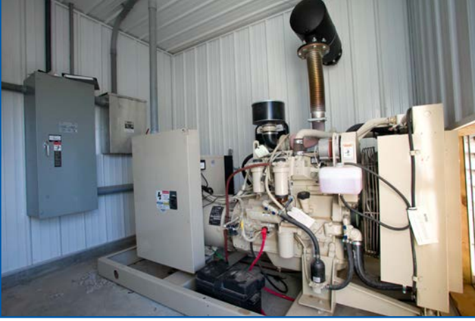
Şekil 97: Kümeslerde kullanılan jeneratör.
