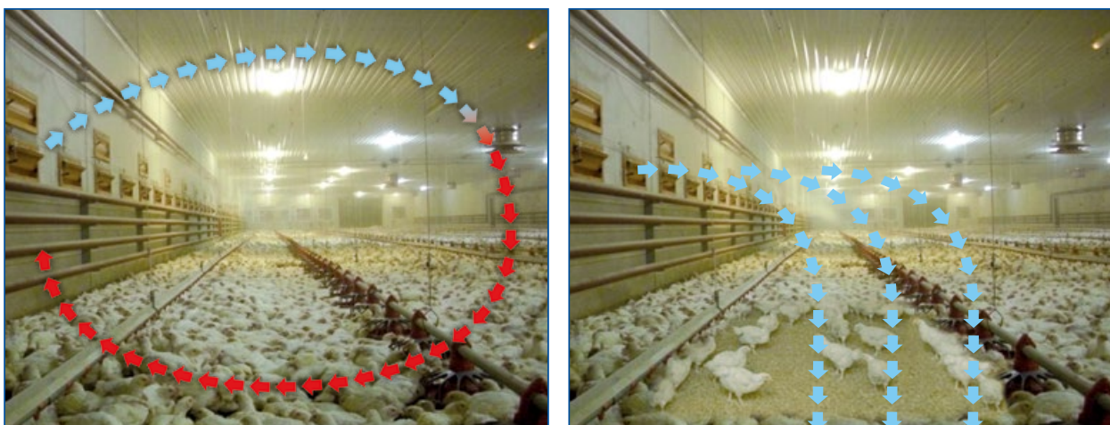
Figura 108: Flujo del aire dentro de la nave. La imagen del lado izquierdo muestra un flujo de aire rápido y correcto durante la ventilación mínima. La imagen del lado derecho muestra un flujo de aire lento e incorrecto durante la ventilación mínima.
