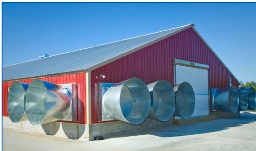
Figura 112: Ejemplo típico de una nave con ventilación de túnel.
