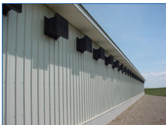
Figura 119: Ejemplo de una trampa de luz ajustada a una entrada de ventilación cruzada.
