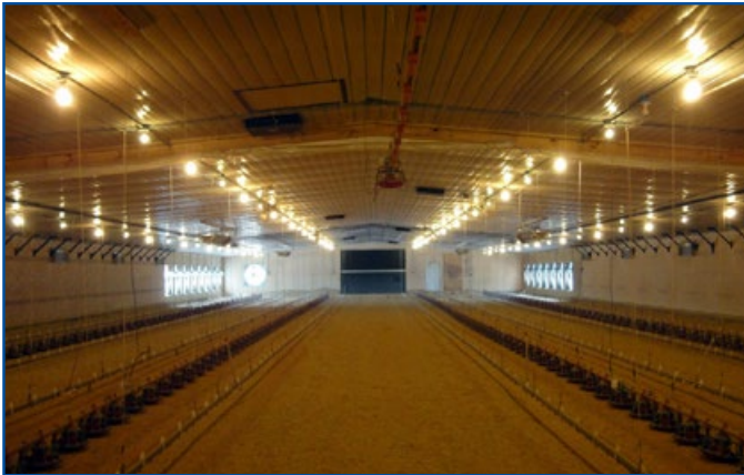
Figura 101: Ejemplo de una nave de ambiente controlado.
