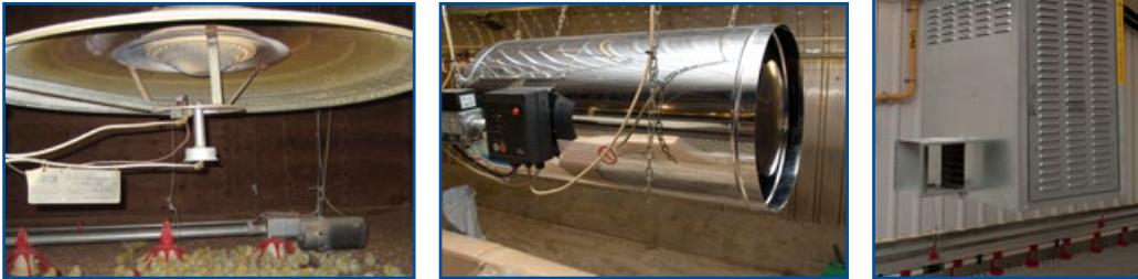
Figura 98: Ejemplos de diferentes sistemas de calefacción (de izquierda a derecha: pantalla de gas, calefacción para toda la nave, calentador portátil).
