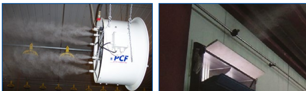
Figura 16: Uso de un aspersor para aumentar la HR durante la cría.
