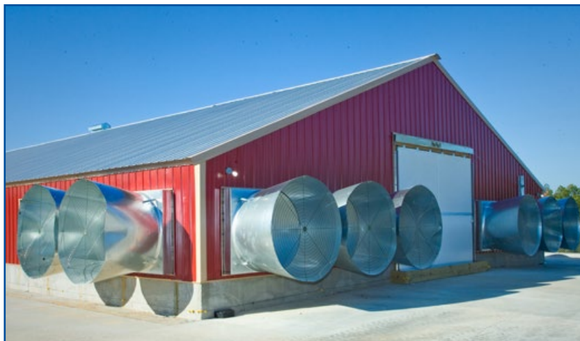
Figura 112: Exemplo típico de aviário com ventilação de túnel.
