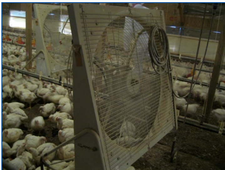
Figura 100: Ventiladores de circulação em um aviário naturalmente ventilado.
