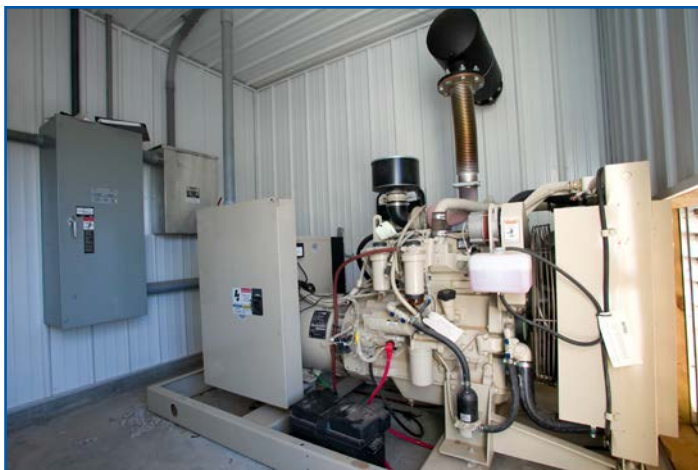
Figura 97: Esempio di gruppo elettrogeno.
