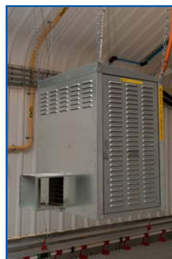
Figura 98: Esempi di impianti di riscaldamento (da sinistra a destra, cappa a gas, generatore d'aria calda con bruciatore interno o bruciatore esterno).
