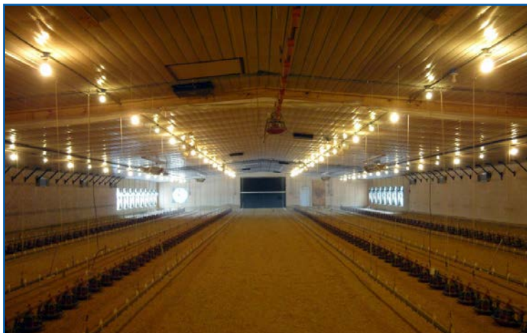
Figura 101: Esempio di ventilazione forzata.
