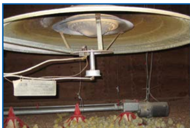
Figura 98: Esempi di impianti di riscaldamento (da sinistra a destra, cappa a gas, generatore d'aria calda con bruciatore interno o bruciatore esterno).
