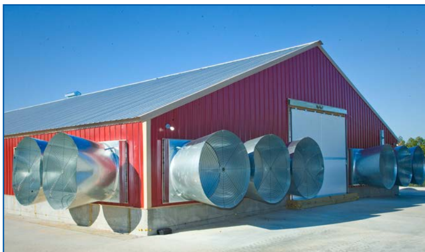
Figura 112: Esempio di ventilazione a tunnel.
