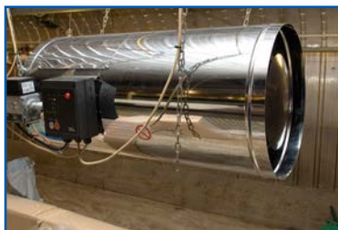
Figura 98: Esempi di impianti di riscaldamento (da sinistra a destra, cappa a gas, generatore d'aria calda con bruciatore interno o bruciatore esterno).
