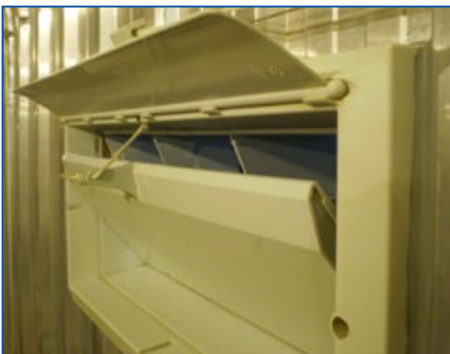
109. ábra: Példa egy jó minőségű légbecéjtőre
